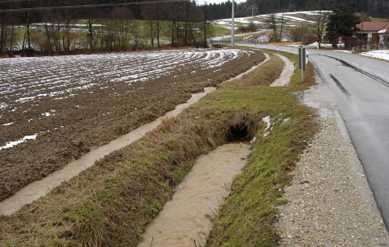
Gräben transportieren z.B. bei Starkregen Wasser und erodierten Boden direkt in die Bäche oder in Siedlungen.
